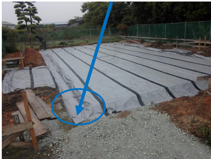
(図4：敷き込み場所)
