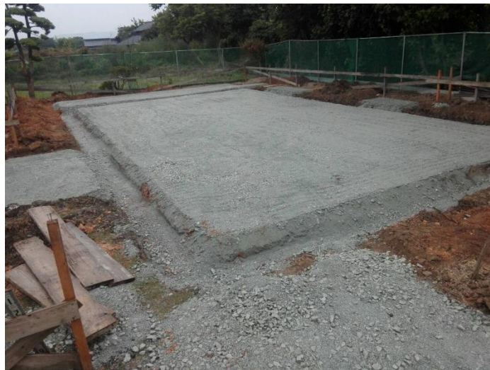
(図1：碎石敷き込み・転圧後)
