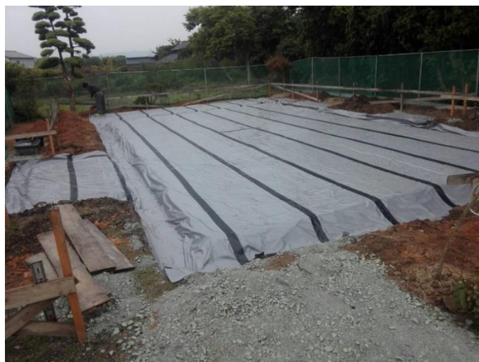
(図2：防蟻・防湿シート敷き込み後)
