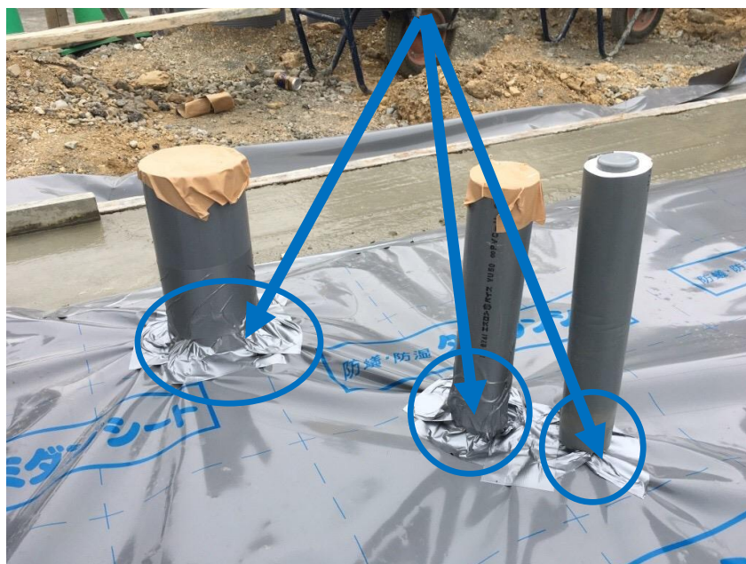
(図 5 : 配管貫通部処理方法)
