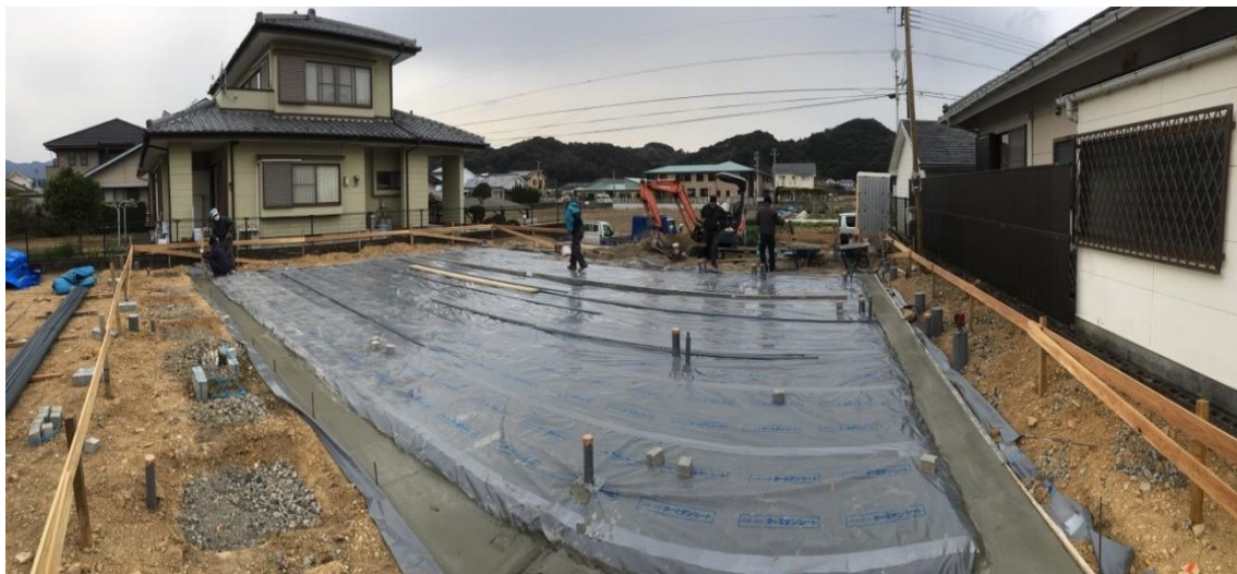
(図 6 : 捨てコン施工後の防蟻・防湿シート写真)
